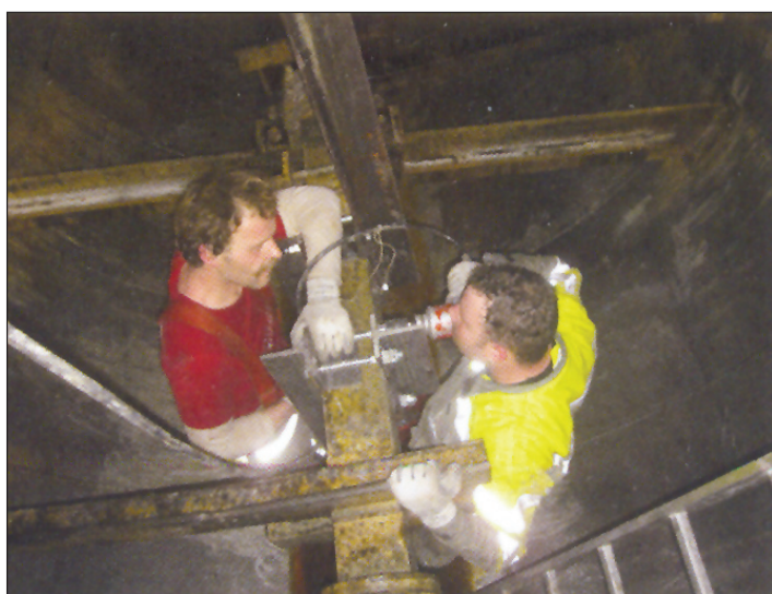
شکل ۱۰: تعمیر همزن مایشه شکر سفید در تاریخ دوم نوامبر ۲۰۱۰
